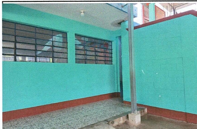
Foto 4: Paredes interiores pintadas.
