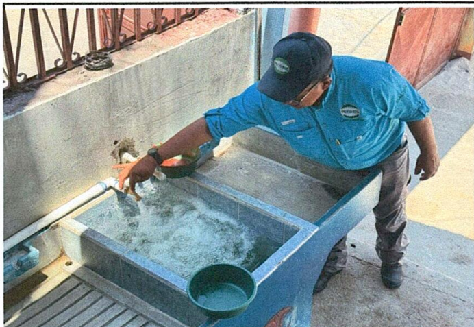
Foto1: Nuevo sistema de tubería instalada.
